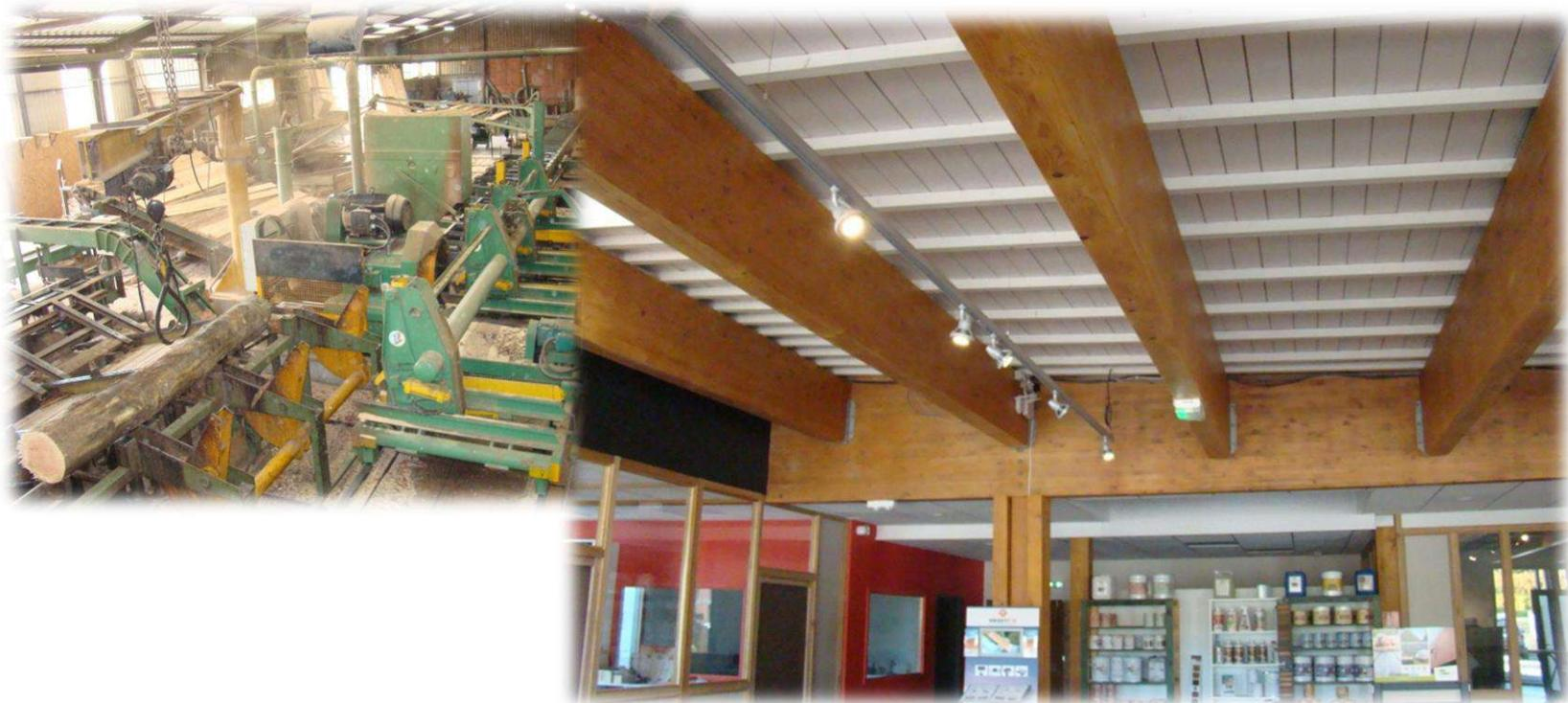
**Pour réaliser la structure poteaux poutre du nouveau négoce, 240 m<sup>3</sup> de sciages bruts en C24 et même C30 issus d'une sapinière du Haut Pilat ont été nécessaires afin de façonner 160 m<sup>3</sup> de lamelles : séchage à 12% et calibrage compris.**
